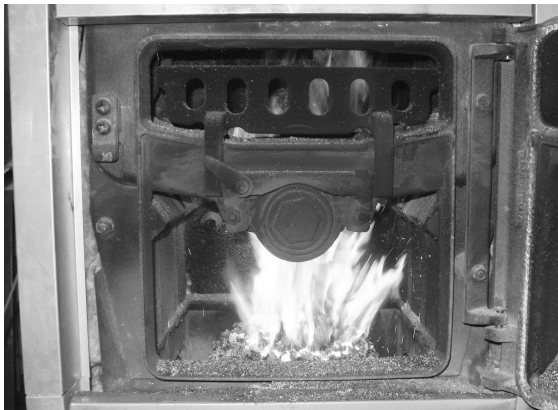
Obr. č. 24 Optimální tvar plamene
